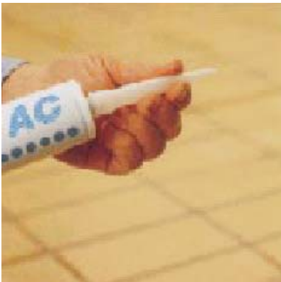
Навинчивание сопла
