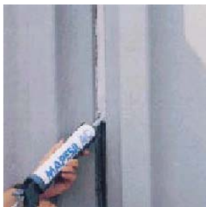
Заполнение швов между блоками сборного железобетона
