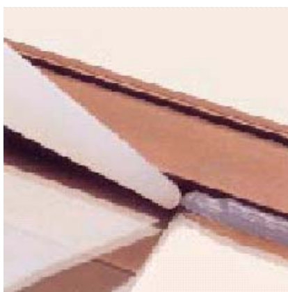
Уплотнение алюминиевой оконной рамы
