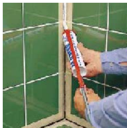
Нанесение MAPESIL AC
