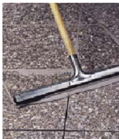
Заполнение швов гранитной облицовки перед полировкой
