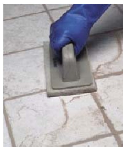
Очистка с помощью мягкой кельмы
