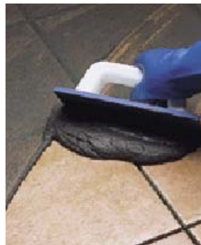
Расшивка однообжиговой плитки с помощью кельмы
