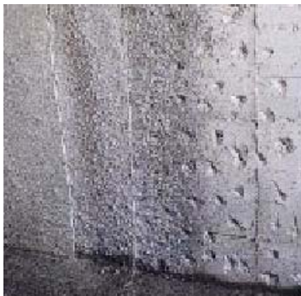
Применение раствора, смешанного с IDROSILEX по бетону
