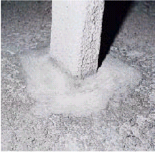
Гидроизоляция колонны с помощью IDROSILEX
