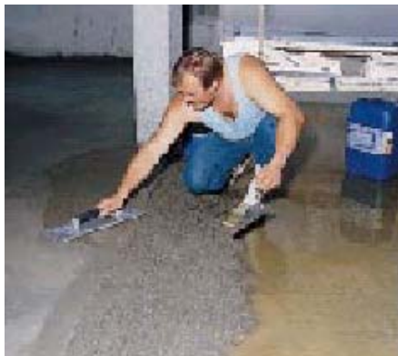
Разравнивание рейкой раствора с IDROSILEX (жидкий)
